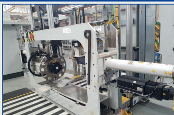
MONTAGENS DE SEDES E VÁLVULAS JW FROWHLICH
